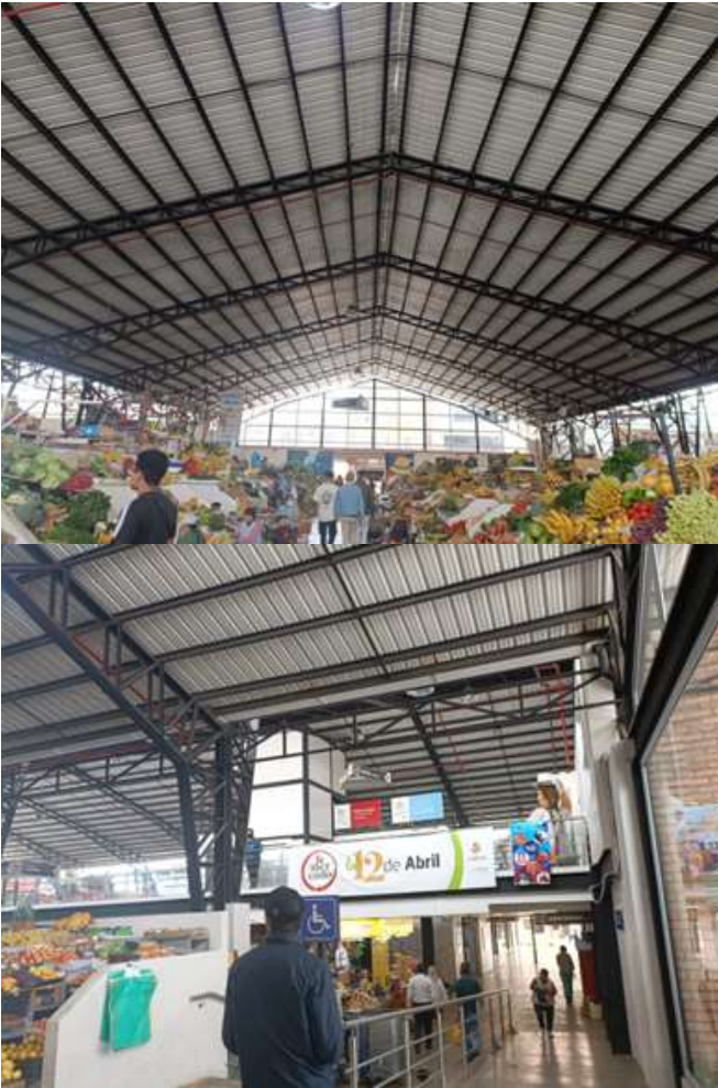
Interior del complejo
